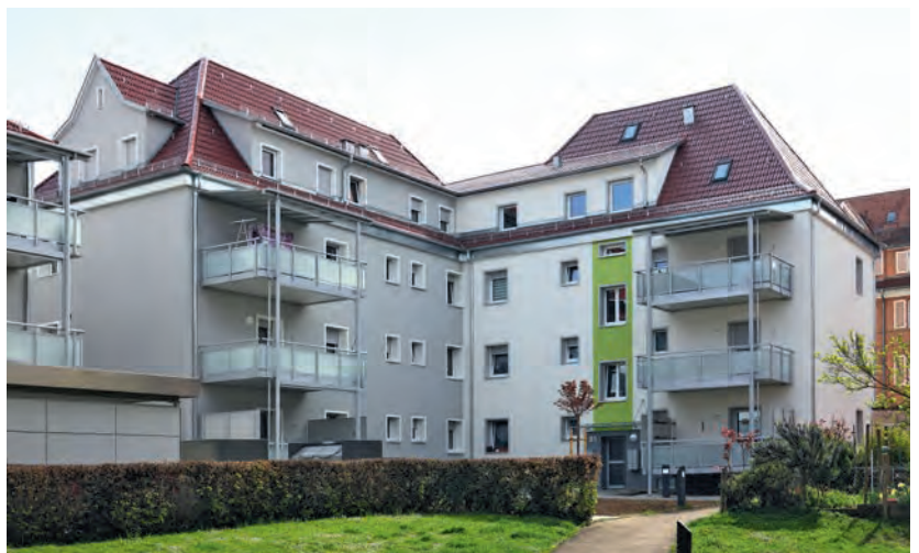
Hofseite mit neuen Balkonen
