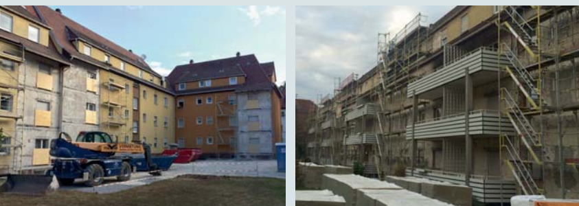
Dächer und Fassaden werden gedämmt
