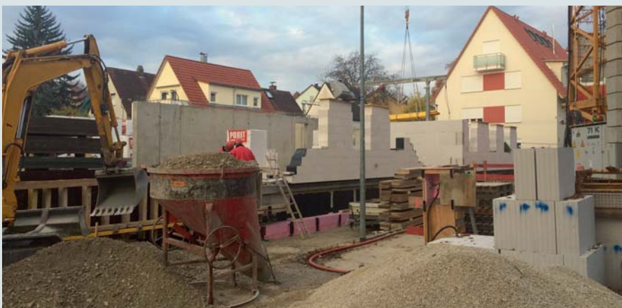
Der Rohbau geht gut voran
