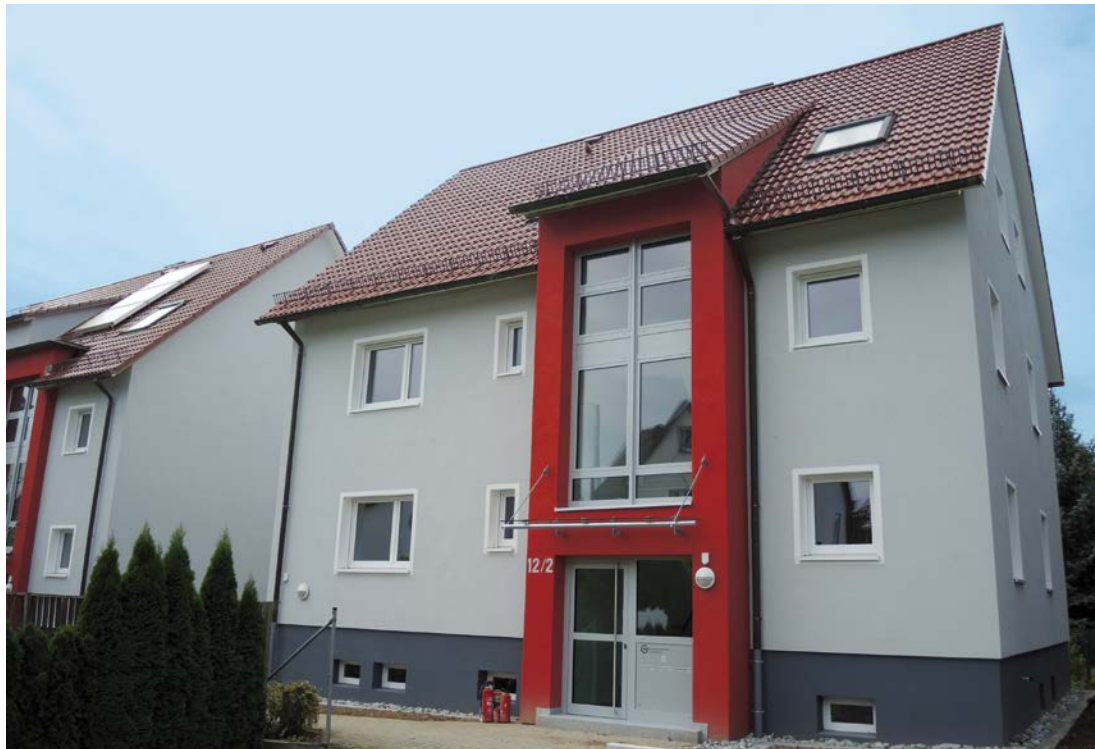
Ein schöner Anblick nach umfangreicher Sanierung.
