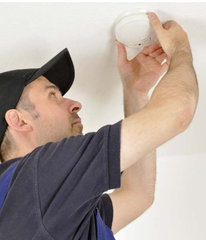
Saubere Montage eines Rauchwarnmelders.
